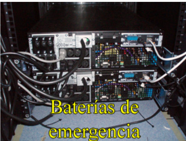
Imagen 3. Fotografía de las baterías de emergencia que alimentan todos los nodos de cálculo y el switch de cada rack . Estas baterías se localizan en el rack , bajo los nodos de cálculo (ver imagen 2). Se usan en caso de corte eléctrico para minimizar las posibles pérdidas.
